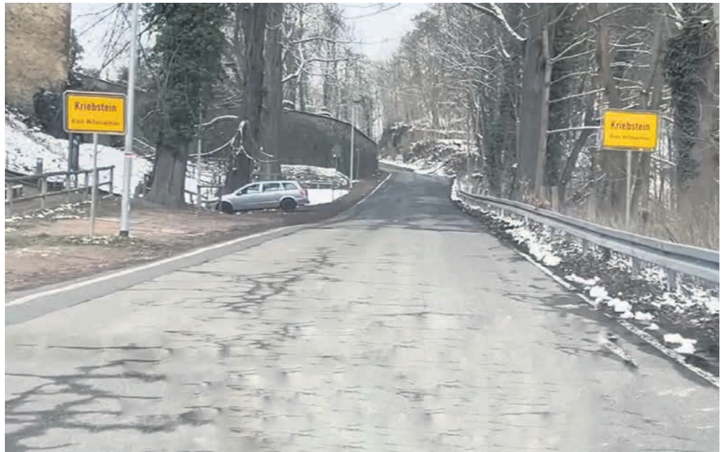
In diesem Jahr soll der sogenannte Burgberg in Kriebstein entschärft werden. Die Kreisstraße gilt als eine der steilsten in ganz Sachsen. Bei der Maßnahme handelt es sich um einen grundhaften Ausbau. Der Freistaat beteiligt sich an den Kosten. Foto: Landratsamt
