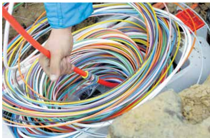
Schon Ende des Jahres könnten die ersten Projekte zum Breitbandausbau beginnen. Foto: Deutsche Glasfaser
